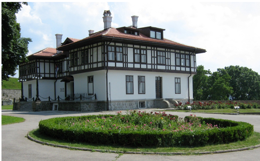
Рис. 2. Здание в Белграде, построенное в конце XIX – начале XX вв. в балканском стиле (Фото автора)
